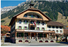
So präsentiert sich das Föllin-Familienhaus nach der umfassenden Renovation in den Achtzigerjahren.
