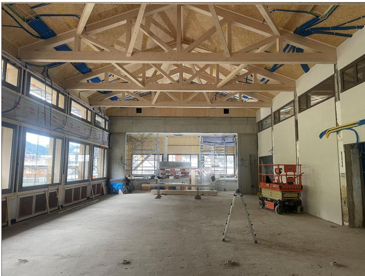
Abbildung 1 Turnhalle mit Anbau Bühne
