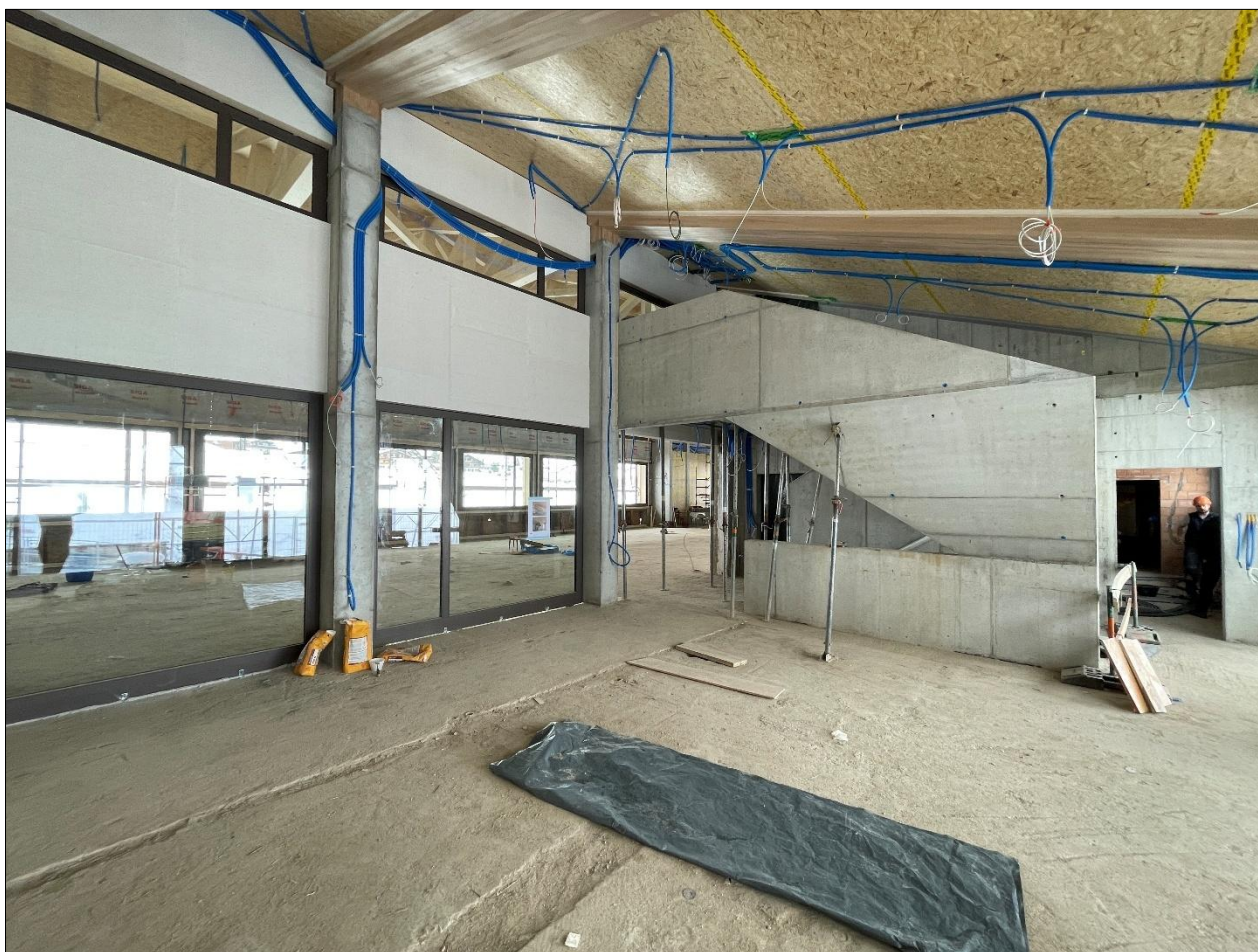
Abbildung 2 Eingangsbereich Turnhalle mit Foyer
